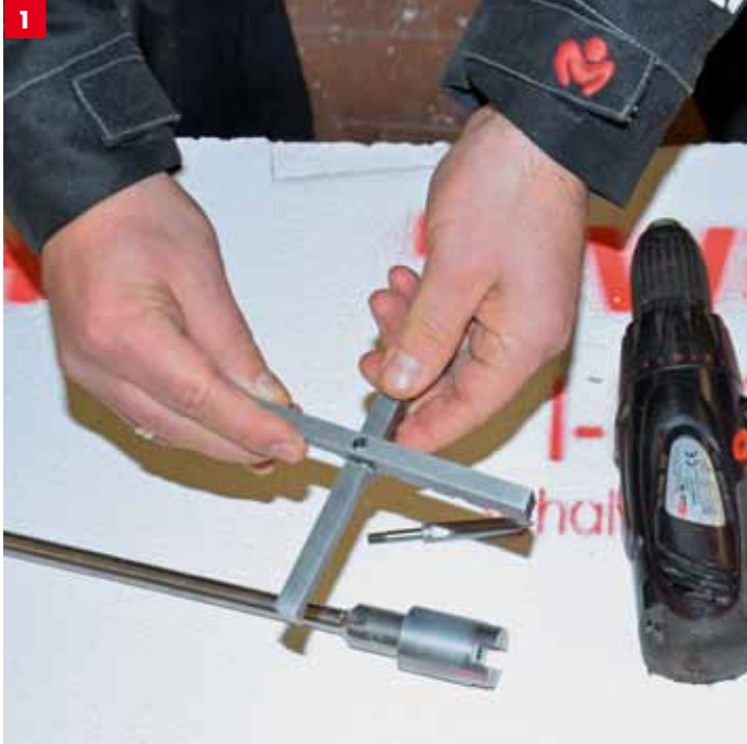
Auswahl des passenden Schneidendurchmessers
